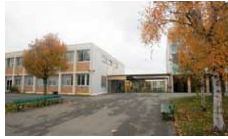
Lycée J.Mermoz: état d'origine avant réhabilitation.
